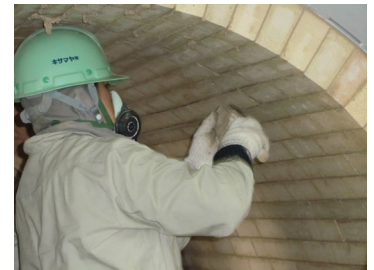
設備を守る耐火物を施工します
