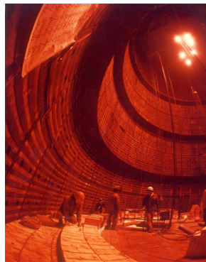
高炉内施工風景
