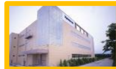
山形県/米沢工場
