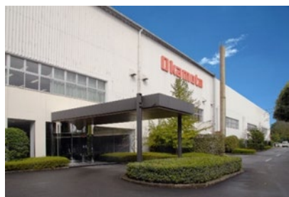
本社／安中工場
