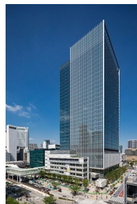
本社入居のビル
