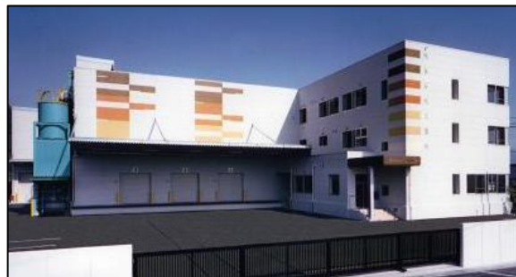
熊本本社外観
