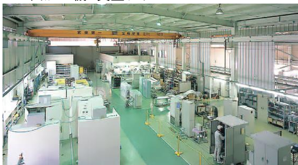
新港町工場 制御盤組立
