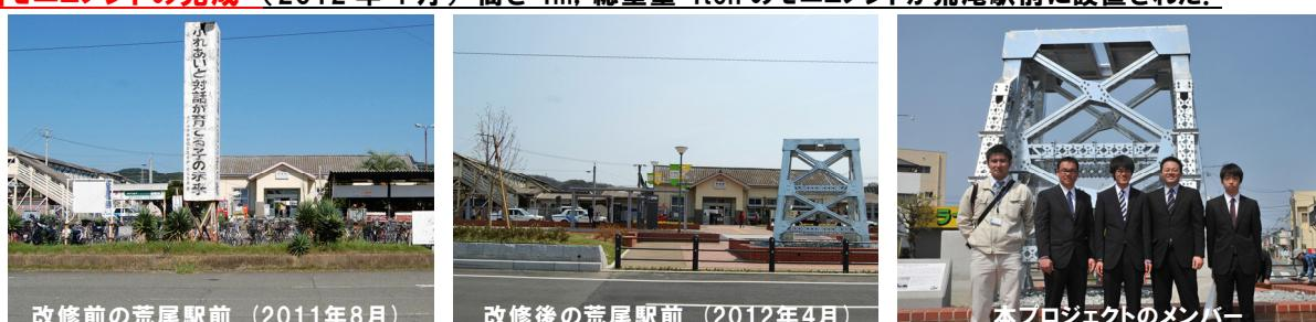
この取り組みで設計・製作したモニュメントは、高さ4m、総重量約4ton、部品点数860点の鉄骨構造である。モニュメントの製作には、荒尾市役所、有明高専、新栄鐵工、豊建設工業、九州オーエムという『地元の技術』を結集して取り組んだ。開鉱以来103年の歴史を持ち、地元の歴史の1ページを作った『炭鉱技術』を表すモニュメントを製作するにあたり、有明広域産業技術振興会より御支援を頂いたことに、心から謝意を表する。
