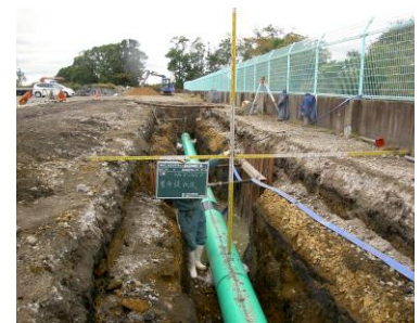
ガス導管敷設状況
