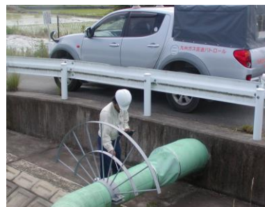
ガス導管安全性調査
