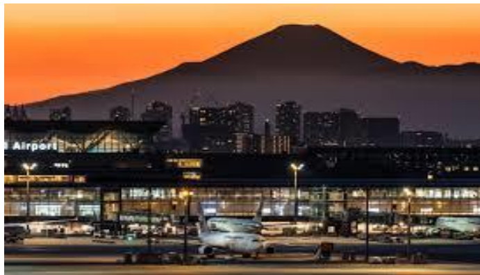
航空灯火設備
