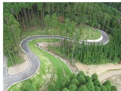
林道仁田坂～国武線 3-2 工区開設工事 (平成28年3月完成)
