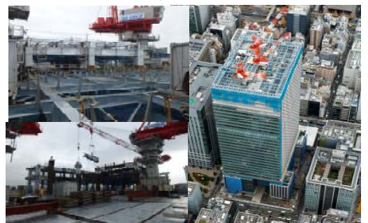
(現場: 東京 京橋 東京駅 八重洲口側)
