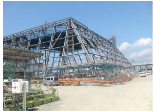
福岡ソフトバンクスタジアム本拠地球場 (現場: 筑後市)
