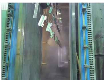
粉体塗装設備
