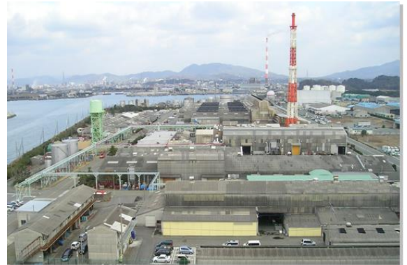
▲本社工場の全景写真
