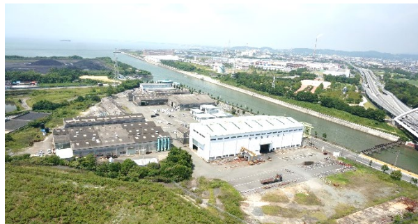
本社工場 全景
