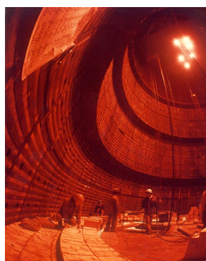
高炉内施工風景
