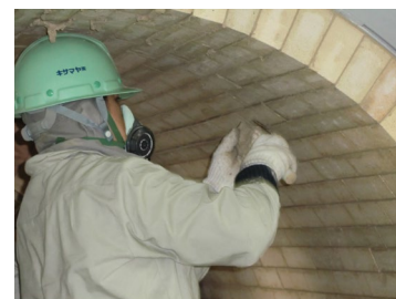
設備を守る耐火物を施工します
