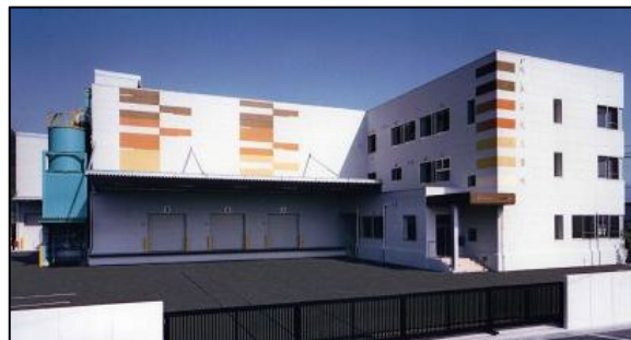
熊本本社外観
