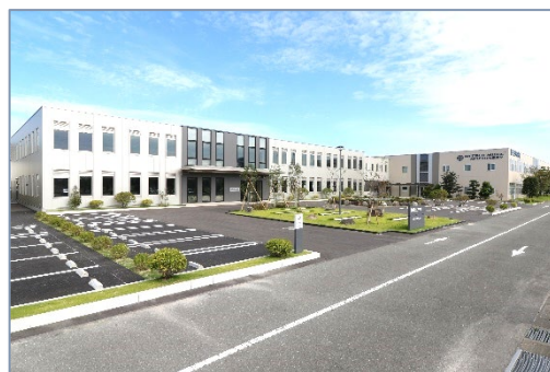
令和2年竣工 技術開発センター
