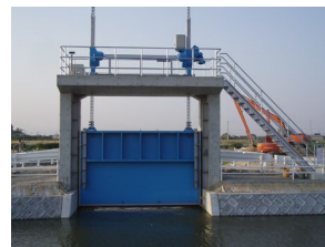
水門ゲート工事
