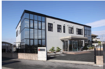
本社事務所外観
