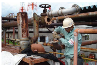
配管更新工事
